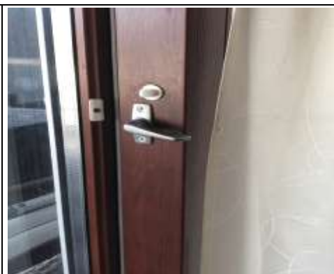
Figur 2 Skyvedør-reil er åpen og døren kan åpnes.
