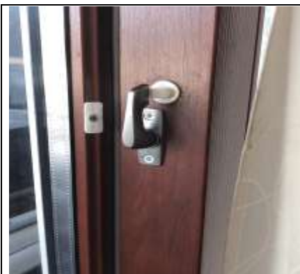
Figur 1 Skyvedør-reil skal være låst når døren er lukket for å sikre døren mot vind og vanninntrengning.
